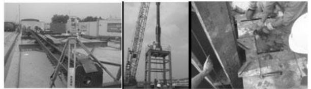
图3-1 型钢立柱现场试拼装及吊装、定位
