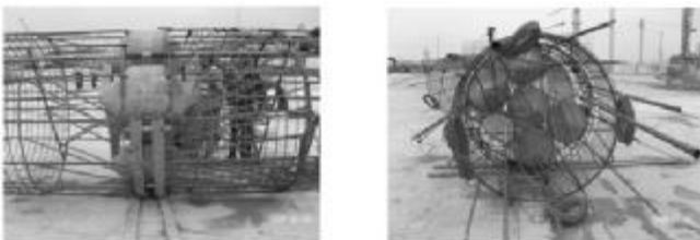
图3-2 荷载箱安装方法示意图
