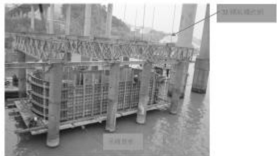
图7 吊箱下放到位
