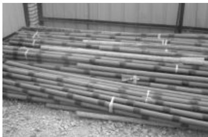
图 1: \Phi 50 袖阀管
