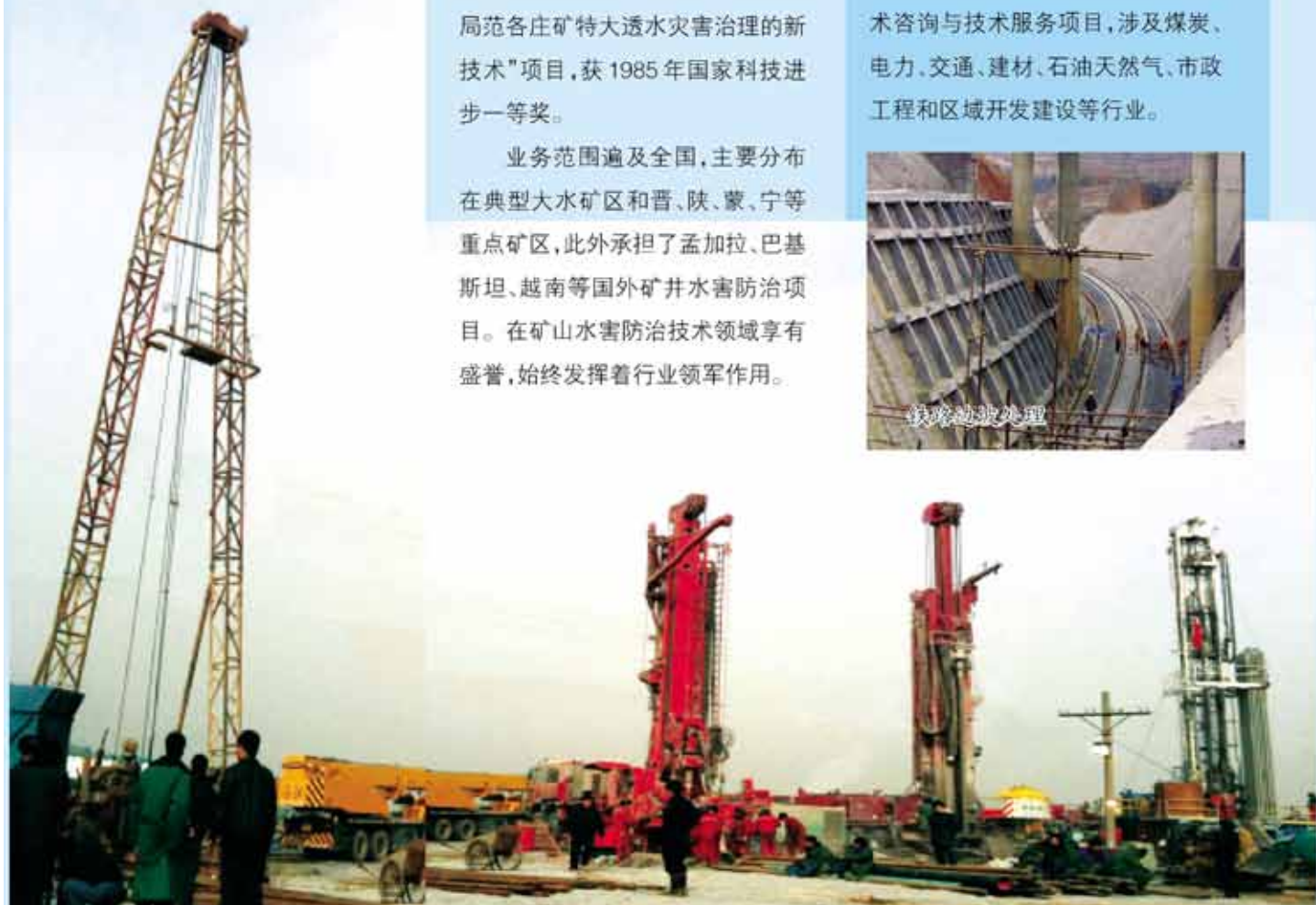
神华路梁山抢险现场
